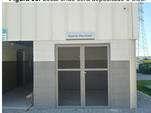
Figura 06: Local onde será depositado o óleo.
