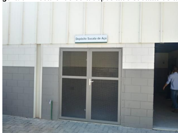
Figura 07: Local onde será depositado sucatas de aço.
