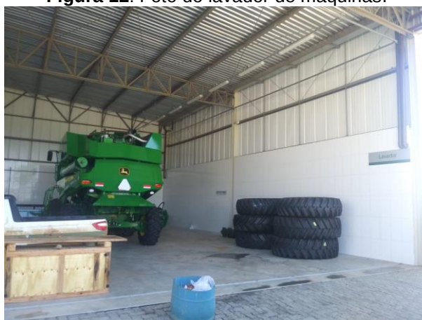
Figura 12: Foto do lavador de máquinas.
